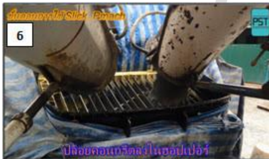
ขั้นตอนที่ 6. ปล่อยคอนกรีตลงในฮอปเปอร์ แล้วเริ่มยิงคอนกรีตจนคอนกรีตออกปลายท่อ
