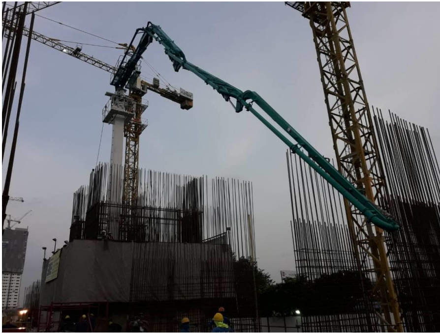
การติดตั้งในช่องลิฟท์
